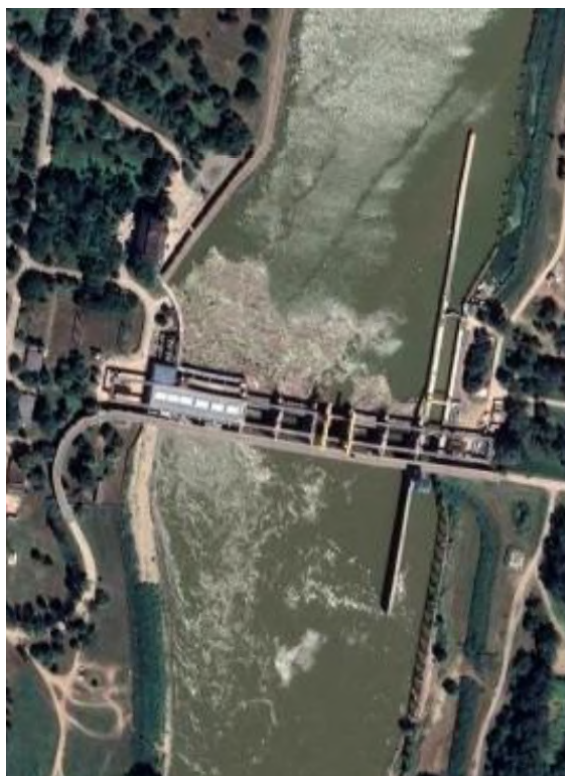
3.2. ábra. Kiskörei vízerőmű. Forrás: Google Earth
